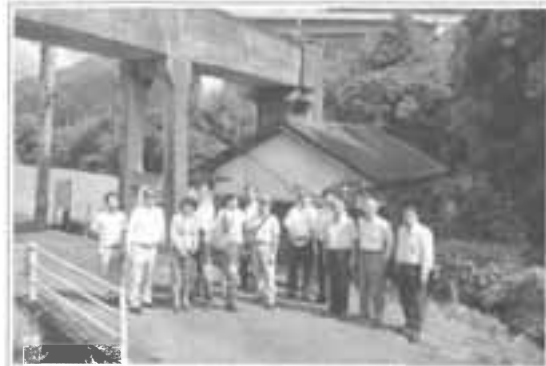
別府電化農業協同組合小水力発電所を訪れた研究者グループ
